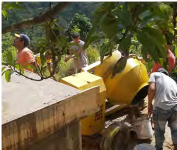
Construcción de obras.
