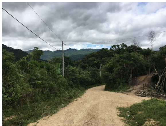
Figura 5. 20 Estado de las vías de acceso a la comunidad El Volcán
